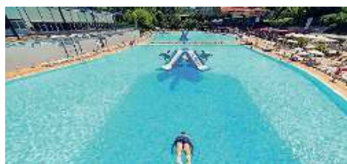
L'IMPIANTO Le piscine monumentali, chiuse da anni
